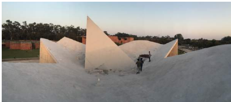
Toit du Gandhi Bhawan en réfection. Source : Getty Foundation.
