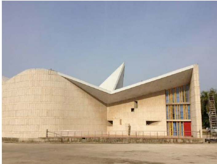
Façade sud-ouest. Source : Célia Houdart
