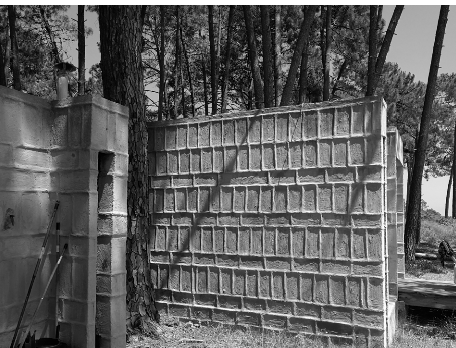
Le premier volume d'habitation, face à la mer
