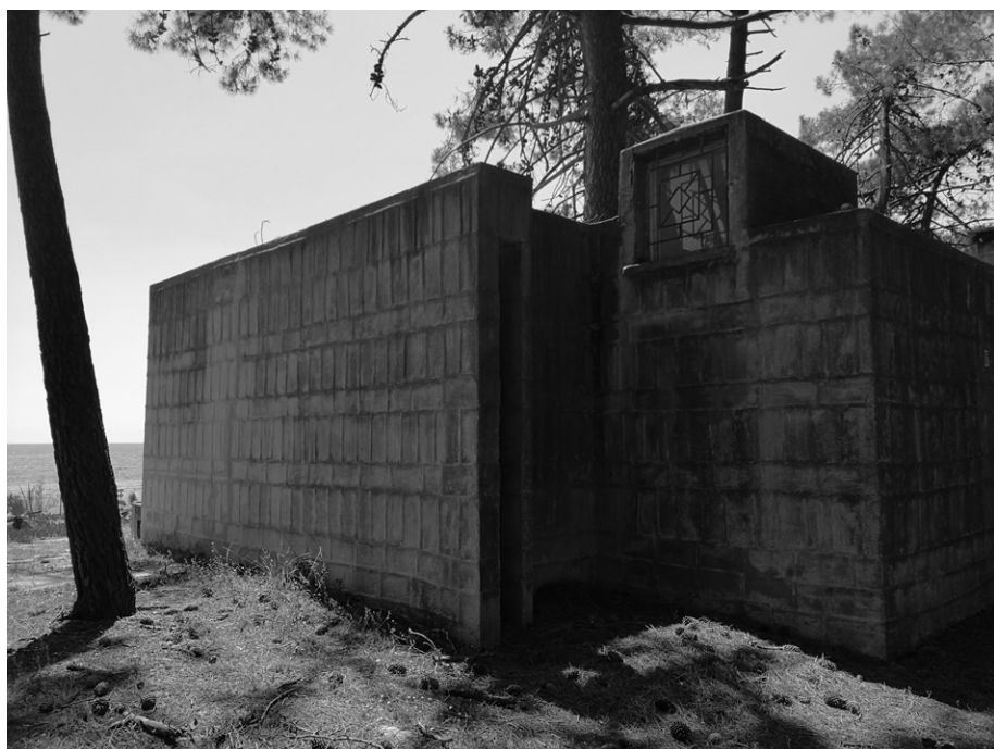
La façade nord-ouest
