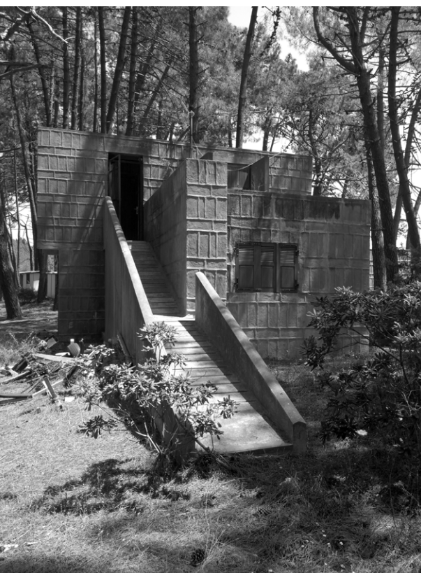
La rampe d'accès à la chambre de l'étage
