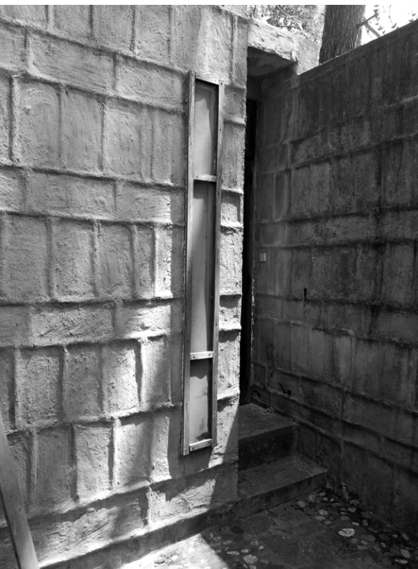
L'appareillage de parpaings à l'entrée de la première chambre
