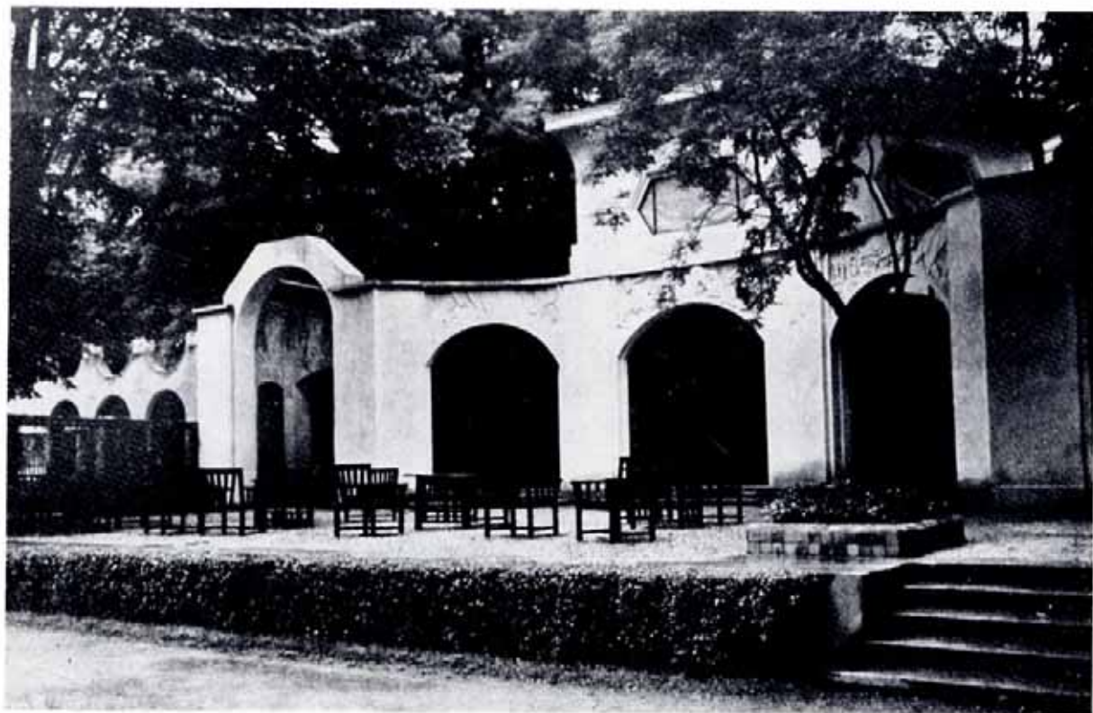
Le pavillon de la S.A.D.G. à l'Exposition internationale des Arts Décoratifs en 1925. Paul Tournon, architecte. Façade sur le jardin. ( L'Architecture , 1925).
